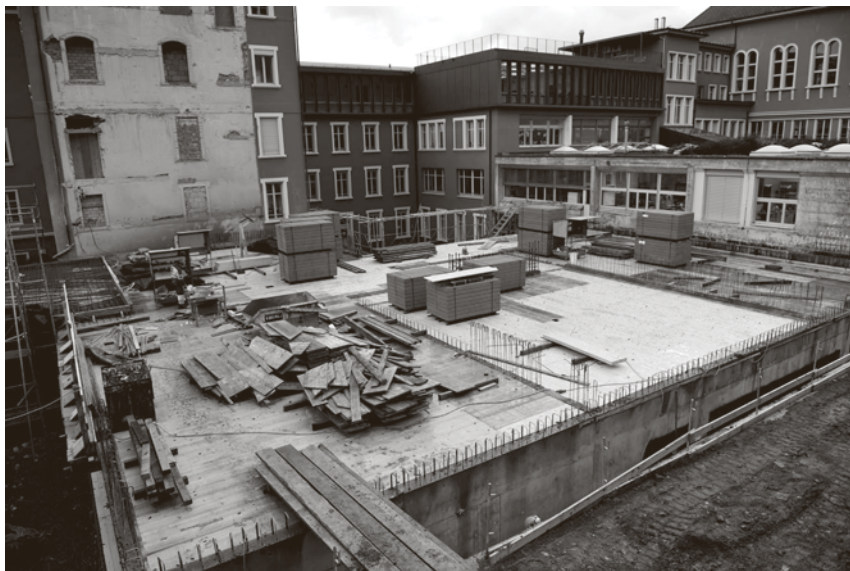
Kaum ist der Philosophentrakt abgerissen, stehen bereits die Grundmauern für den Neubau.
